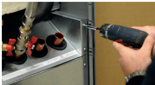
3. Skru kølemodulets skruer af.
