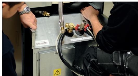
4. Træk kølemodul ud ved først at løfte forkanten lidt op ved hjælp af bærehåndtagene.
